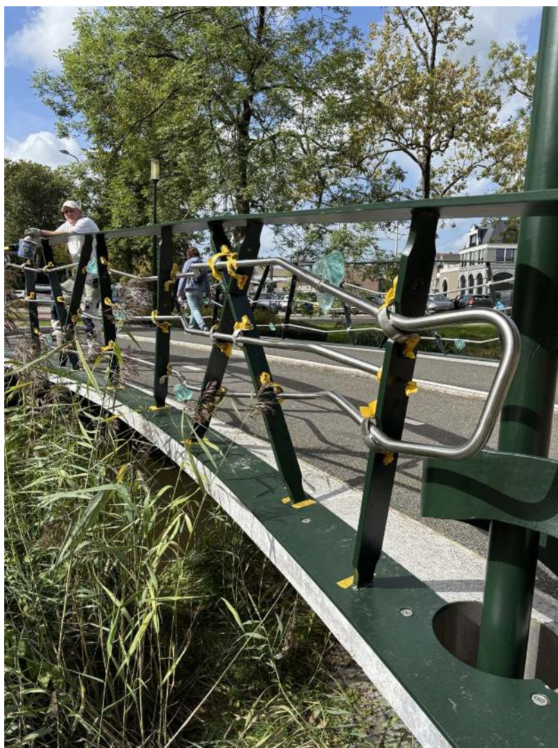
Aanvullende uitvoering van de herstpunten na oplevering. Status: uitgevoerd.
