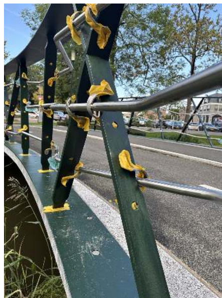
Detail van de beschermde verbindingen tijdens de werkzaamheden.
