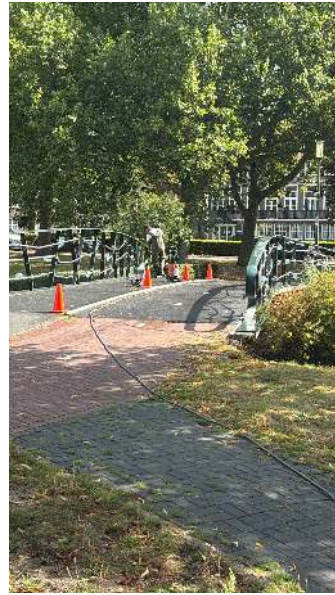
Totaalbeeld van de brug tijdens de werkzaamheden.
