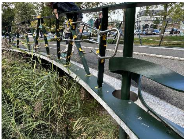
Uitvoering aan de buitenzijde van de brugleuning.
