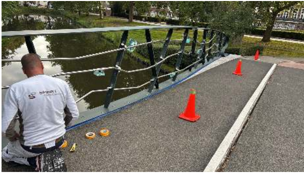
Werkvak veilig en overzichtelijk ingericht tijdens de uitvoering.
