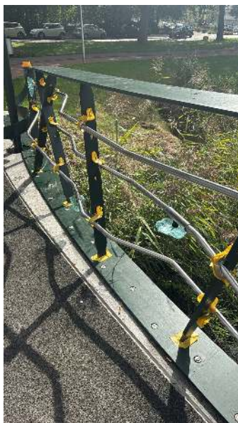
Detailopname: zorgvuldig afplakken en beschermen van aansluitingen en RVS-delen.
