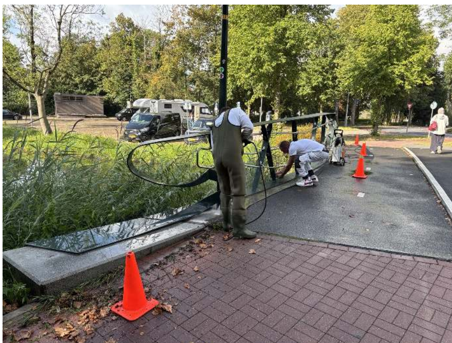
Uitvoering ter plaatse met afzetting van het directe werkgebied.
