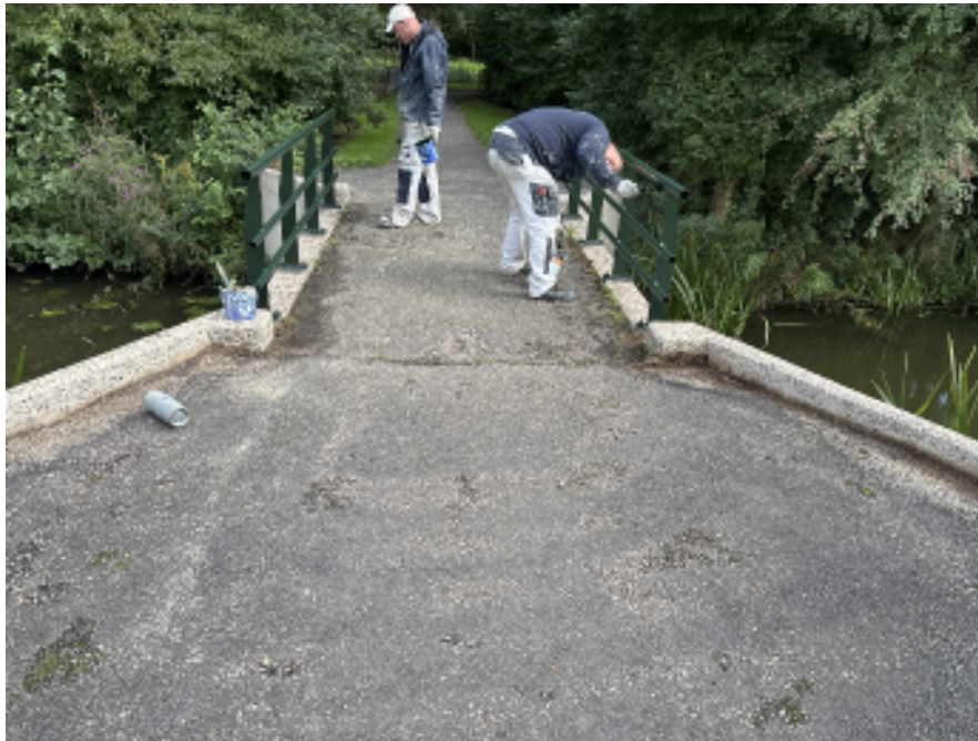
Foto 1. Uitvoering schilderwerk aan de brugleuningen.
