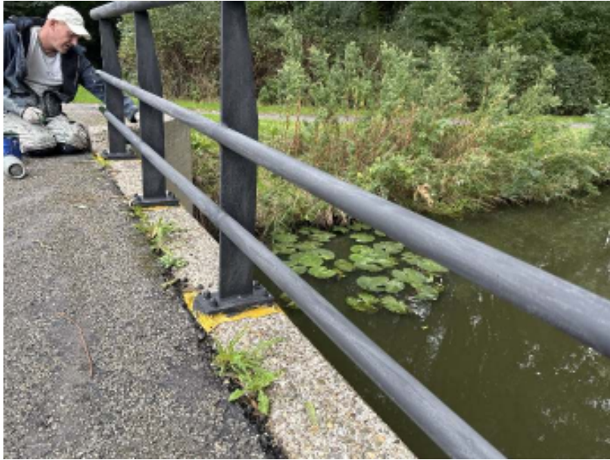
Foto 9. Detail van de voorbereide / behandelde ondergrond tijdens uitvoering.
