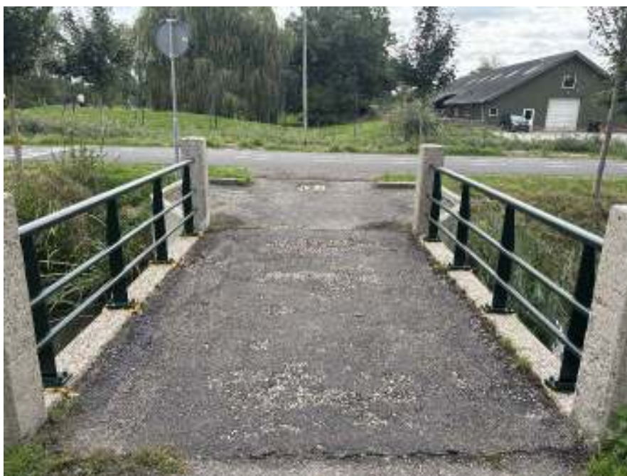
Foto 8. Detail tijdens uitvoering - behandeling van buizen, staanders en voetplaten.
