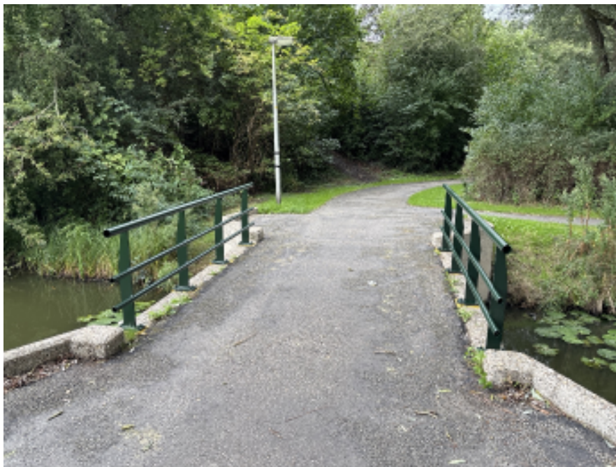
Foto 3. Opgeleverde brugleuningen - gelijkmatige donkergroene afwerking.
