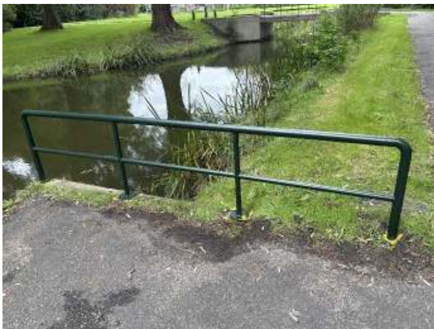
Foto 5. Afzonderlijk hekwerk langs de watergang - eindresultaat.
